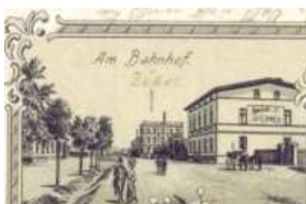
Dworzec kolejowy w 1905r.
